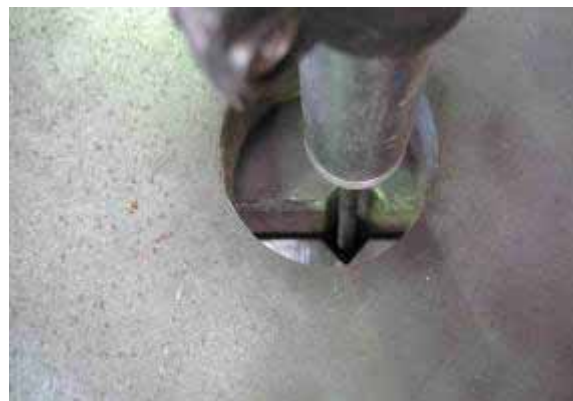
写真 3-12 変位計設置状況（細部）
