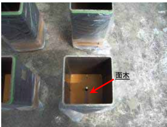
写真 3-1 型枠内 面木設置状況
