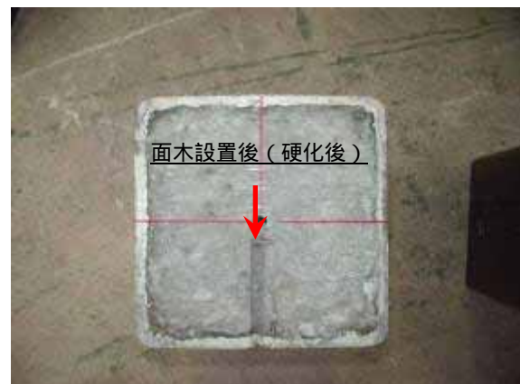
写真 3-2 硬化後 面木設置された箇所
