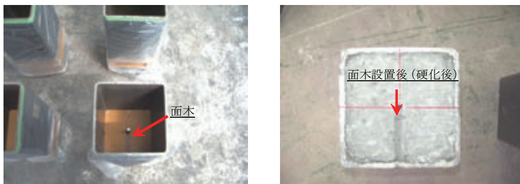
図 7-3-13 面木設置状況
