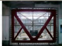
【補強】枠付き鉄骨プレースを設置する工法の例
