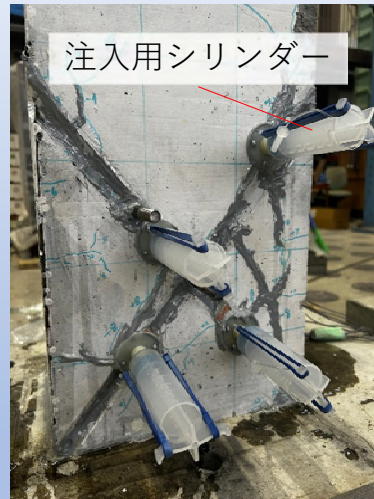
ひび割れ補修の様子
