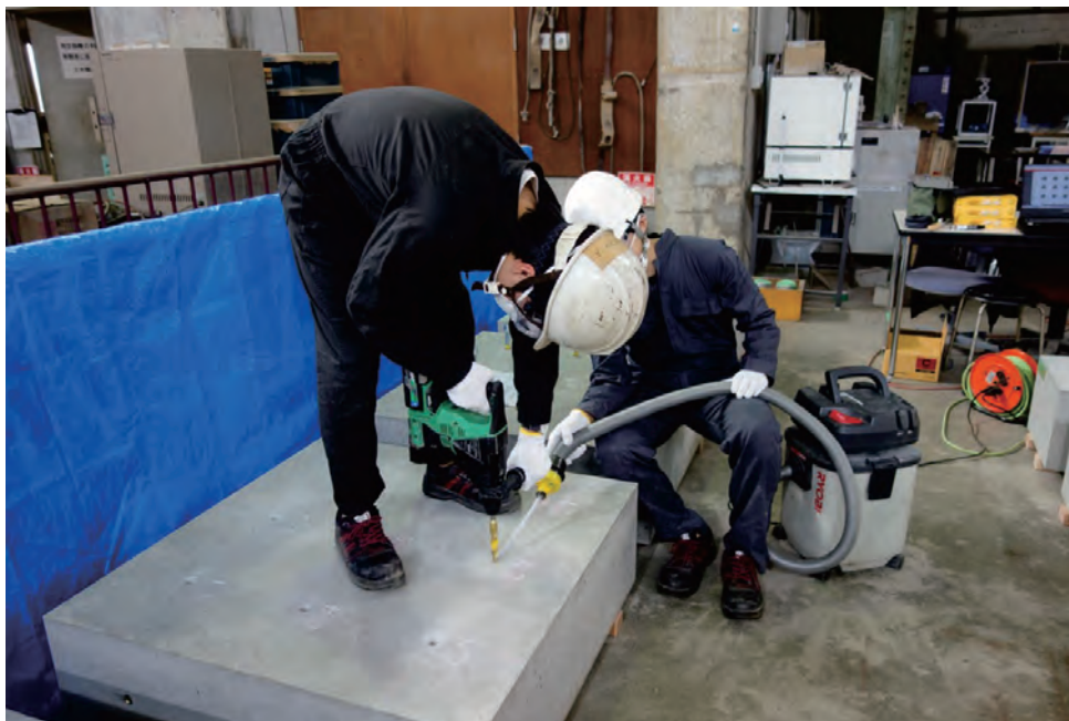
学生により施工（施工要領について学習済み）
